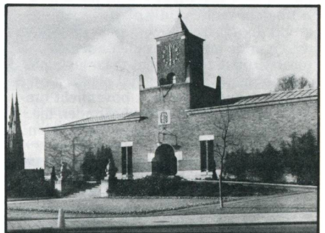
Het Van Abbe-museum in Eindhoven op een foto uit 1957. Duidelijk is de gesloten structuur te zien. De ramen naast de ingang horen bij de entreehal. De opbouw van de toren is in een later stadium van het ontwerp verkleind omdat bleek dat hij schaduwen in de zalen zou veroorzaken. Foto: Rijksdienst voor de Monumentenzorg.
